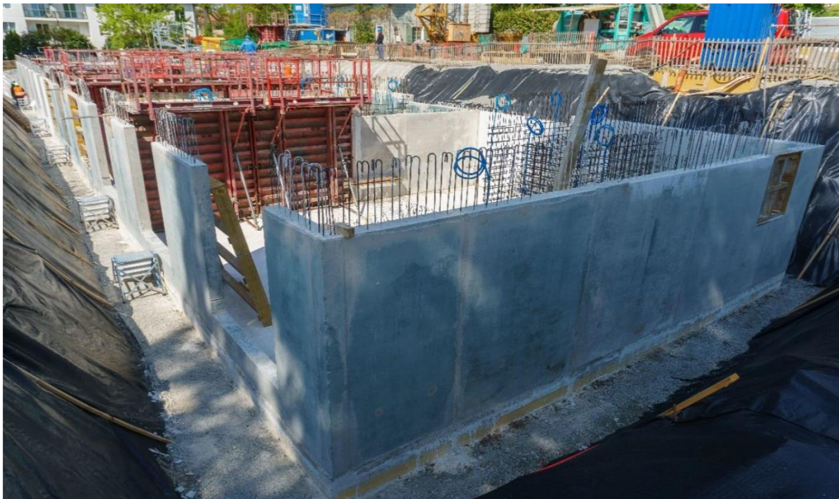
Lancement du chantier du Chêne-Blanc sur la commune d'Onex en Suisse
