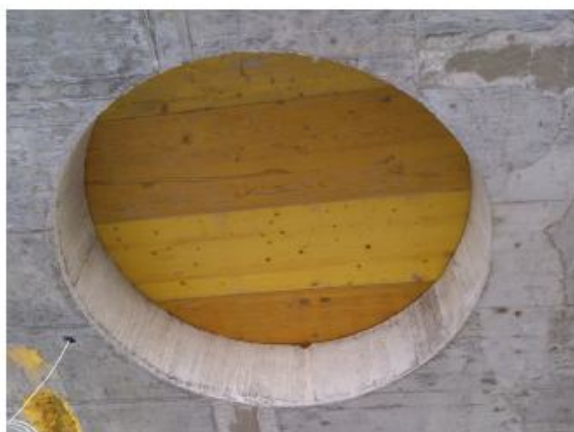
Fenêtre au plafond fait avec un mannequin circulaire au Boudines
