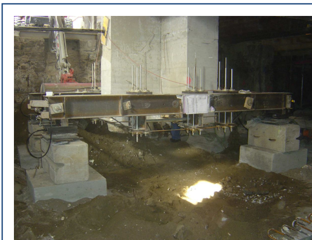
Détails (vérinage des piliers)
